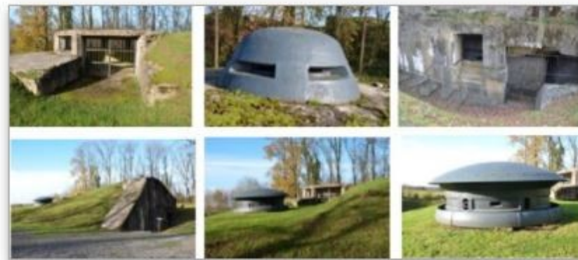
Matériaux utilisés pour le renforcement du fort à partir de 1900
